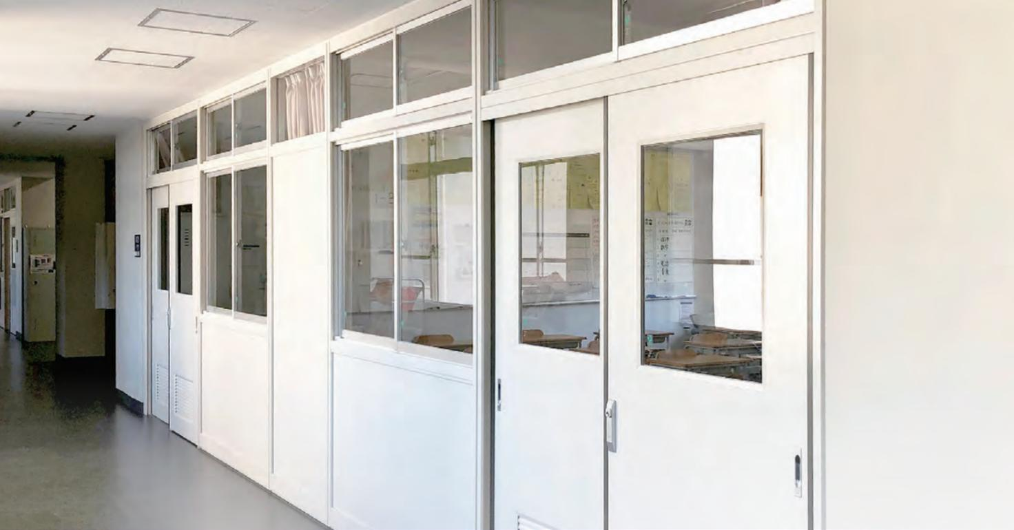
移設や組み替えが手軽にできる高耐震性の可動間仕切
